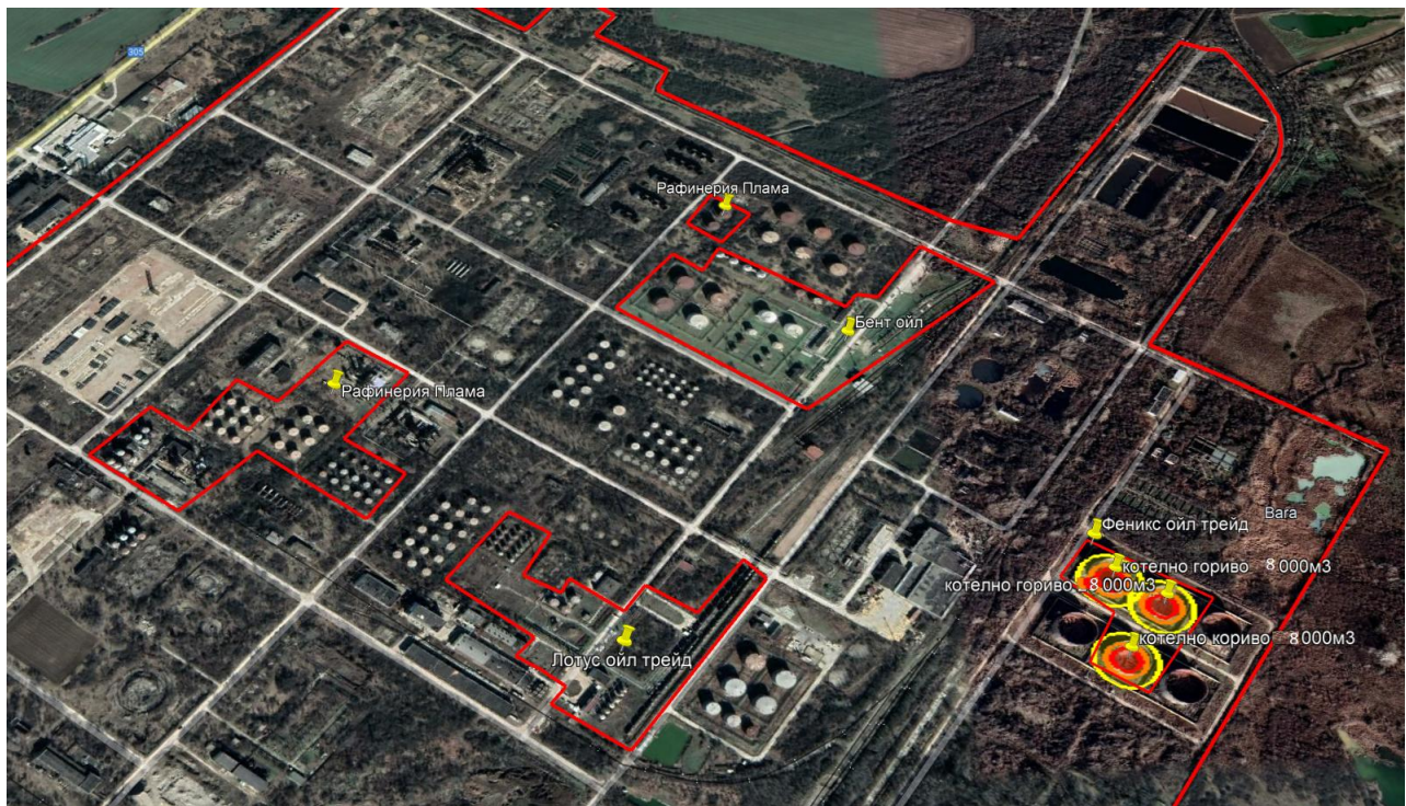
Фиг. 4-5-8-2 Въздействие на пожара от повърхността на разлив от котелно гориво върху площадката на „Феникс ойл трейд“ ЕООД и съседните обекти
